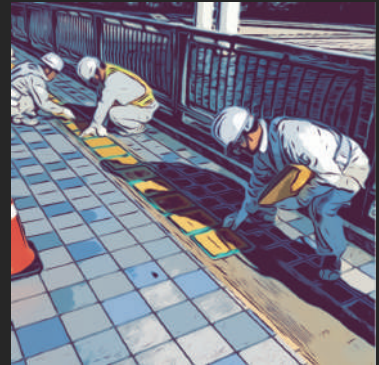
3. プレート設置
