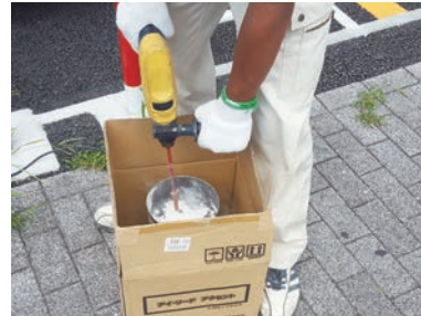
② 樹脂・骨材・硬化剤の混合
