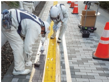
④ 専用ローラーで塗布 (0.2~0.25 kg/m 路面状況により異なります)
