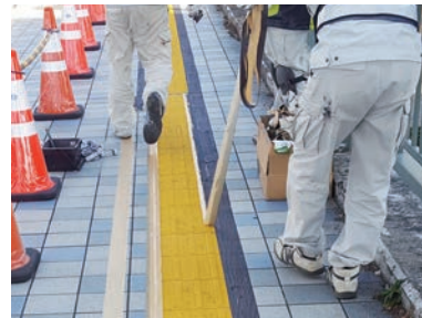
⑤ マスキング除去・硬化養生
