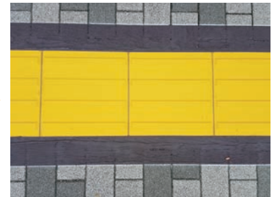
⑥ 硬化したら完成
