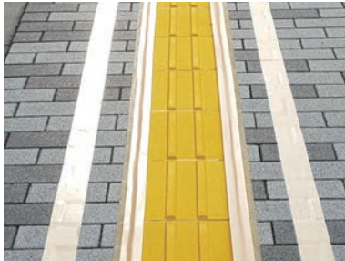
① 養生・マスキング
